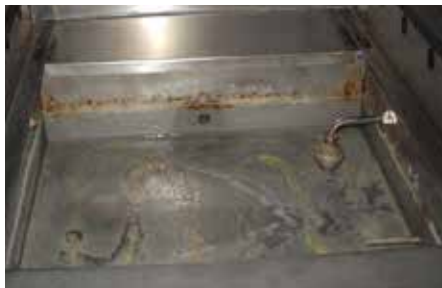
Antes de la instalación de Vulcan – incrustaciones de cal acumuladas en la superficie del lavabo
