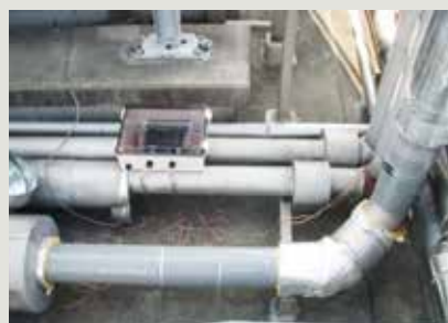
Instalación de Vulcan S100
