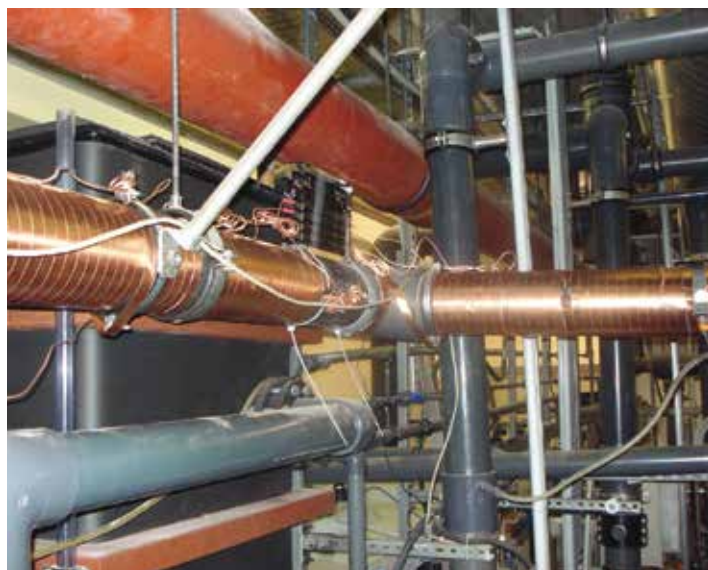
Vulcan S250 tratamiento de tuberías principales de agua para la piscina y la zona de Spa Meridan
