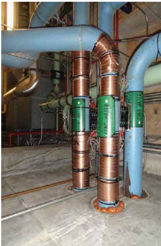
Unidades Vulcan S100 instalados en el doble chiller
