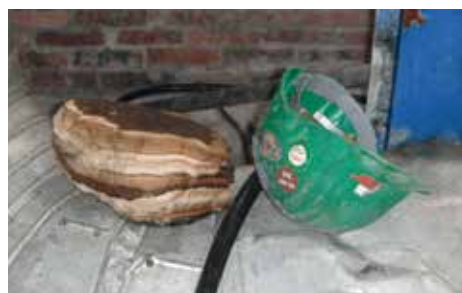
Depósito eliminado de la tubería después de la instalación de Vulcan
