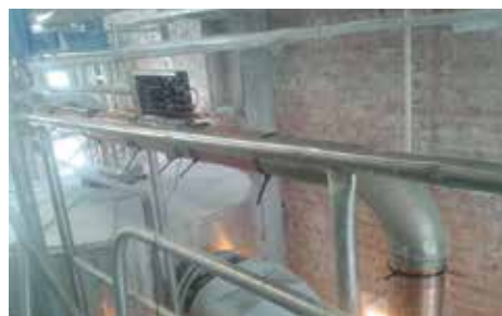
Instalación de Vulcan S100 para la cal del horno
