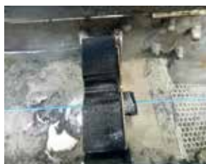
10 de mayo: La máquina 2 sin Vulcan, la cal se deposita en paredes y bobinas.
