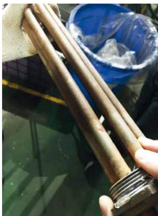
Después instalar Vulcan por un año y medio, las incrustaciones han desaparecido sin mantenimiento adicional.
