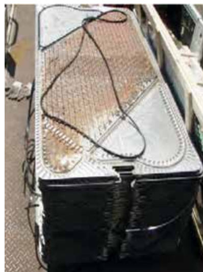
9 meses después de instalar Vulcan: intercambiador de placas desmontado para limpieza.
