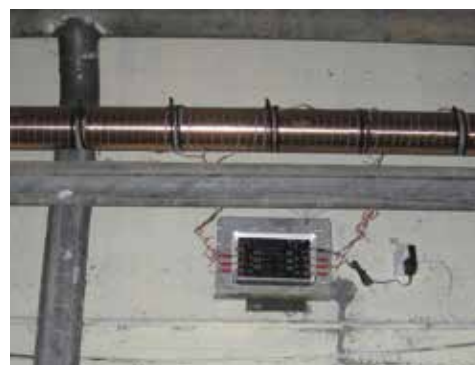
Instalación de Vulcan S100
