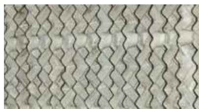
5 meses después de instalar Vulcan: se ha reducido la cal.
